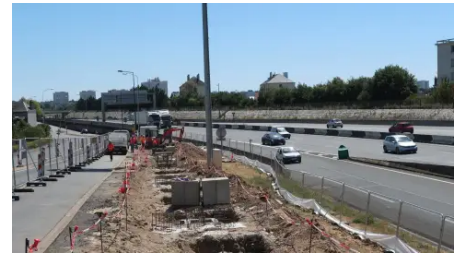
Tours : le premier mur antibruit photovoltaïque en construction sur l'autoroute A 10
